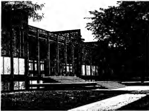
Figure 15. S. R. Crown Hall.
